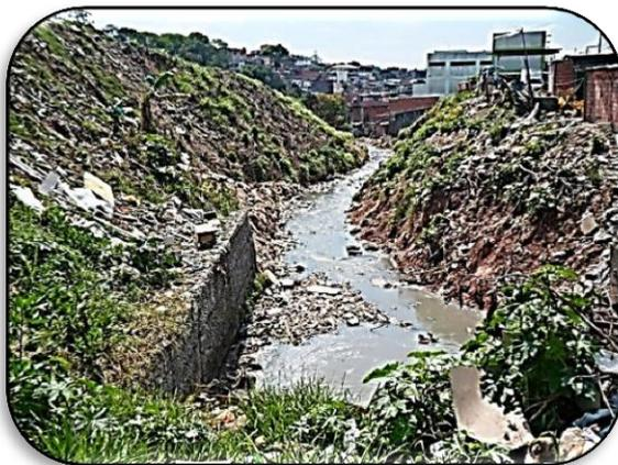
**Afluente do Córrego Pirajuçara assoreado devido à presença de solo proveniente de escorregamentos**
